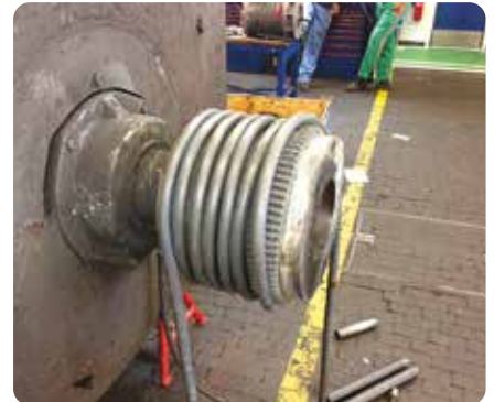
Erwärmung einer Kupplung zur Demontage
