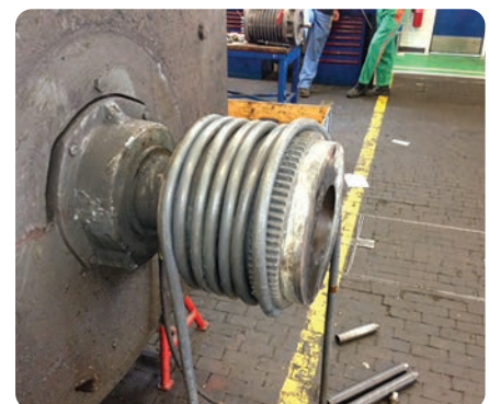
Erwärmung einer Kupplung zur Demontage
